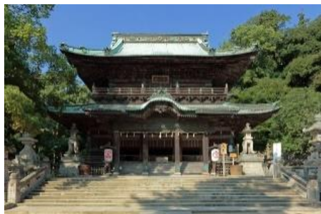
▲江戸末期に建てられた旭社は、1982年に国の重要文化財に指定されました。神仏分離以前、金毘羅大権現の金堂として建立されたものが今に残っています。軒や梁、柱、扉にある人や鳥獣、草花など見事な装飾は必見。
